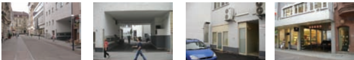
Bestandssituation der Zugänge in den Hofraum
