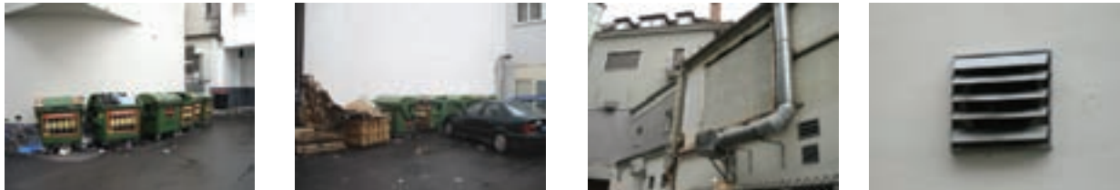
Bestandssituation Müllsituation, Anlagen der technischen Infrastruktur an den Fassaden
