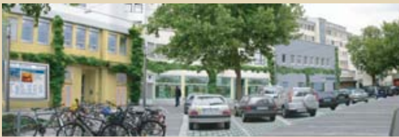
Neugestaltung von Bodenbelägen und Beleuchtung, Öffnung von Fassaden, Fassadengestaltung mit Farbe/ Begrünung
