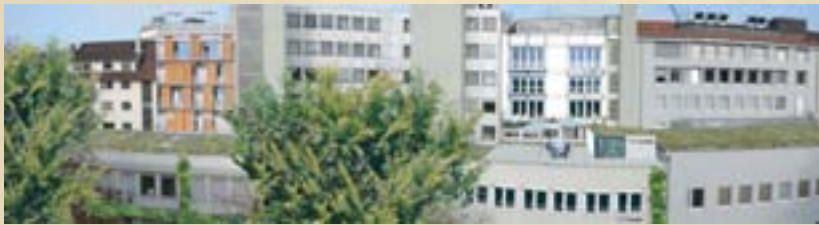
Umnutzung von Obergeschossen zu Wohnungen, Flachdachbegrünung und Bau von Dachterrassen
